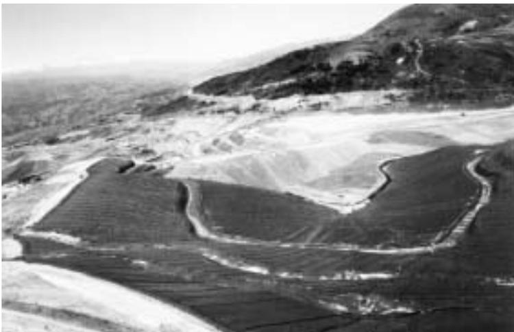
Figura 3.1: Construcción de un “pad” en la mina Pierina, Perú
