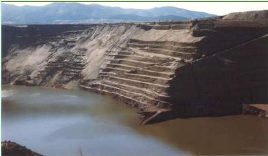
Figura 25. Minas de Alquife, Granada. Situación de los antiguos bancos de explotación y de la inundación de la antigua corta.
